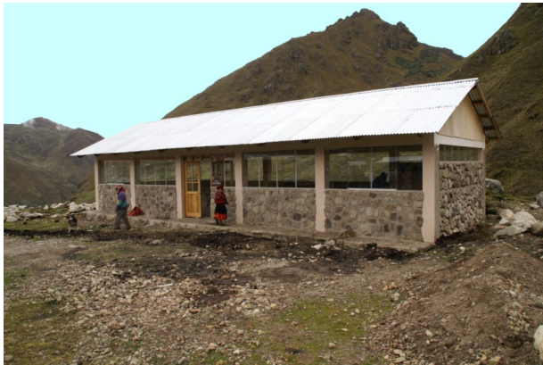
Einer der Speisesäle mit Küche
